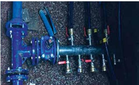
Nourrice permettant le raccordement des particuliers au réseau d'eau potable au Grand Nant.
